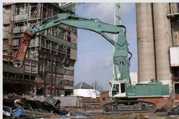
« Example 3 – 2P boom, Kobelco SK230SR
